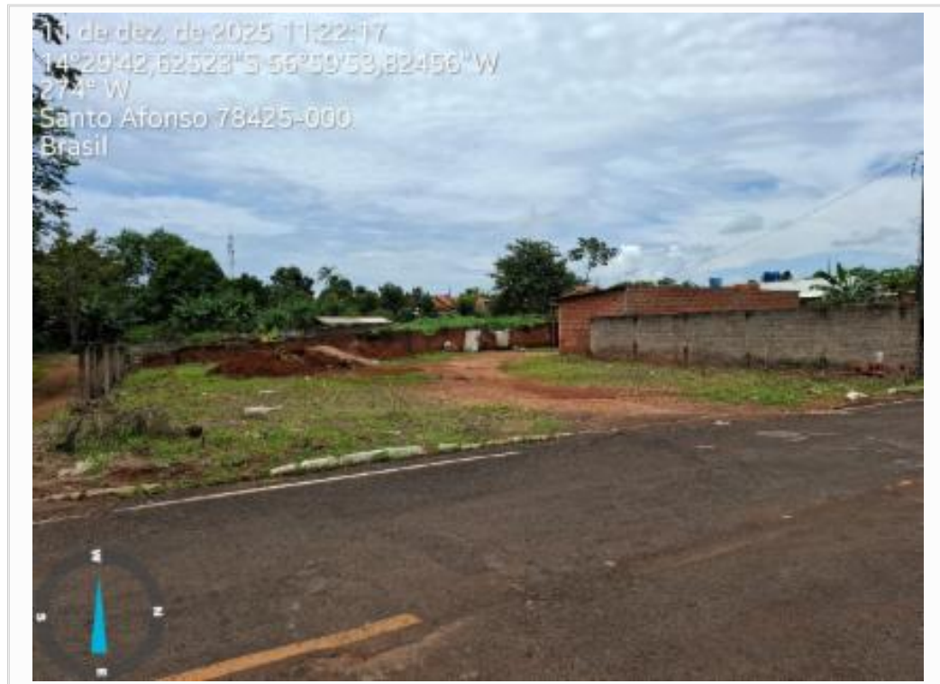
C_FOTO_09 Fachada do avaliando.jpeg
