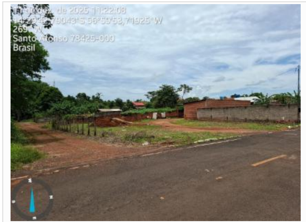
C_FOTO_07 Fachada do avaliando.jpeg
