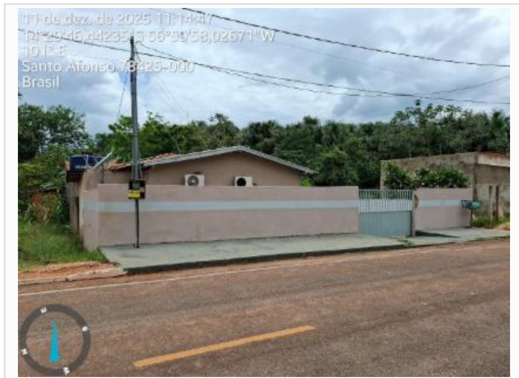
C_FOTO_07 Fachada do avaliando.jpeg
