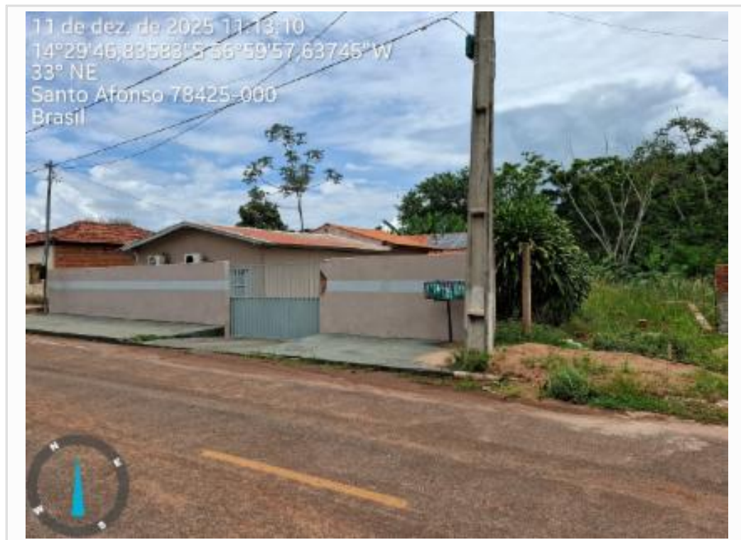
C_FOTO_09 Fachada do avaliando.jpeg
