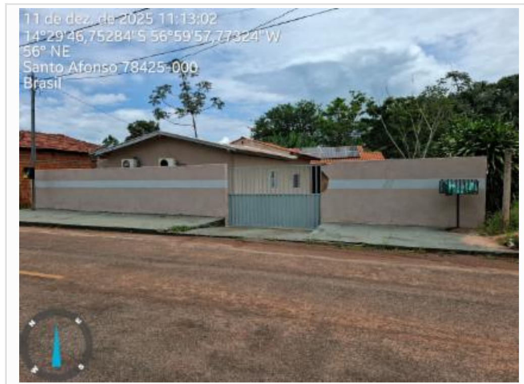
C_FOTO_06 Fachada do avaliando.jpeg
