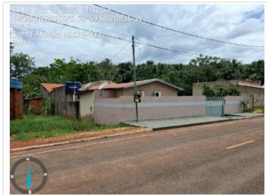
C_FOTO_08 Fachada do avaliando.jpeg
