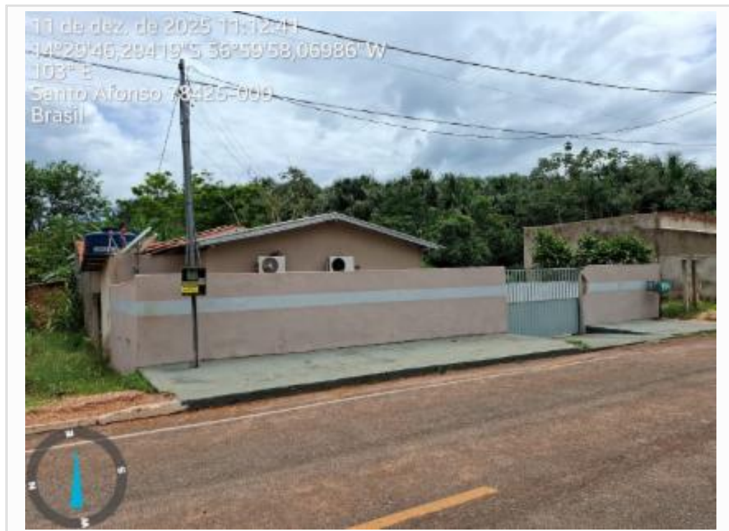
C_FOTO_11 Fachada do avaliando.jpeg
