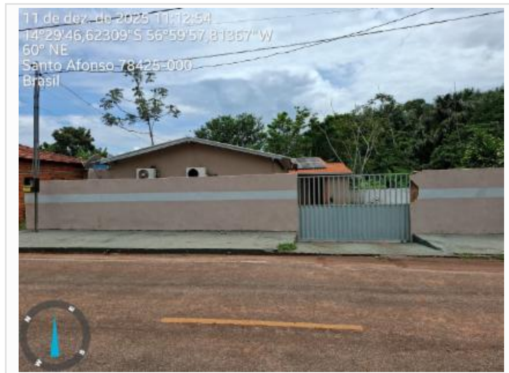
C_FOTO_10 Fachada do avaliando.jpeg
