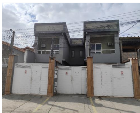
Fachada do avaliando
