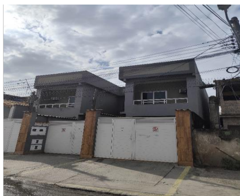
Fachada do avaliando
