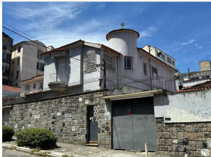
Fachada do avaliando, vista 01
