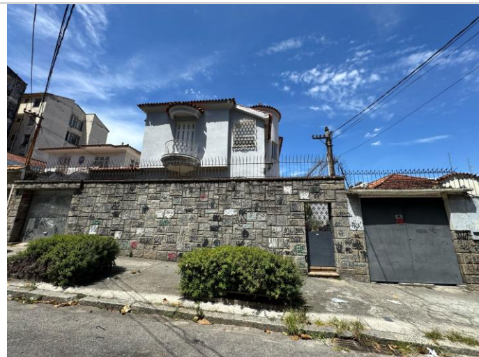
Fachada do avaliando, vista 02
